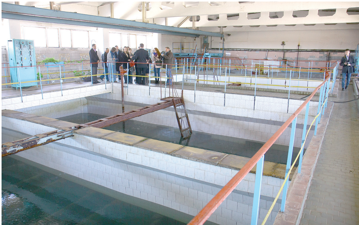
В бассейнах через толщи песка вода проходит очищение.
